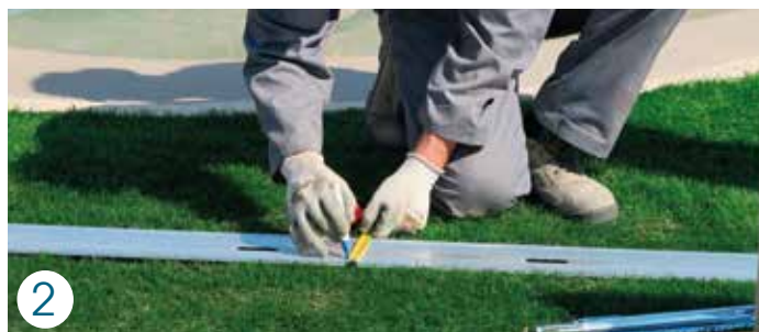
2 Misurazione lunghezza e segno per taglio a misura. Measuring the length and marking a sign for cutting. Längenmessung und Markierung für den Zuschnitt. Mesure de longueur et de marquage pour découpe.
