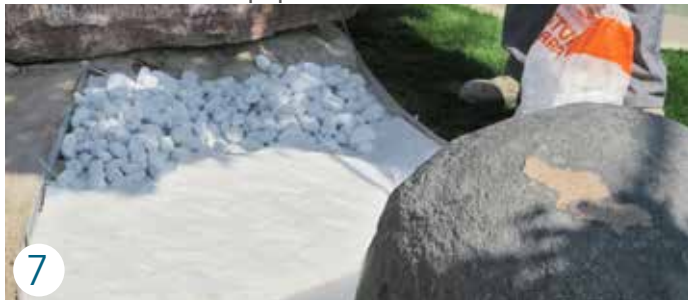
7 Stesura del telo in tessuto non tessuto. Spreading of the non-woven fabric. Ausbreiten der Vliesstoffbahn. Étalement de la feuille de tissu non tissu.
