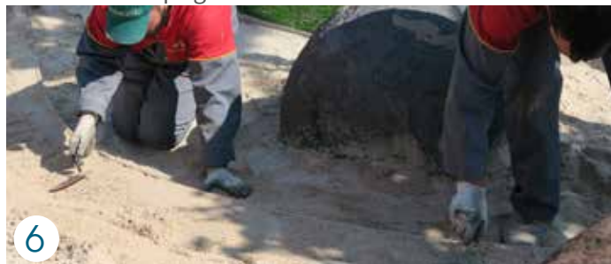
6 Compattazione del terreno intorno alla bordura. Compacting soil around the edging. Bodenverdichtung um die Grenze herum. Compactage du sol autour de la bordure.
