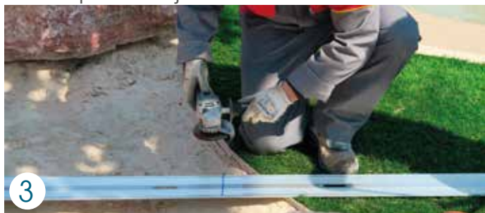
3 Taglio a misura. Cutting to size. Zuschneiden. Coupe à la taille.
