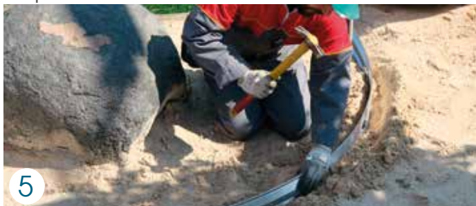
5 Ancoraggio al terreno con picchetti o altri metodi. Anchoring to the ground with stakes or other methods. Verankerung im Boden mit Pfählen oder ähnlichem. Ancrer au sol avec des piquets ou d'autres méthodes.
