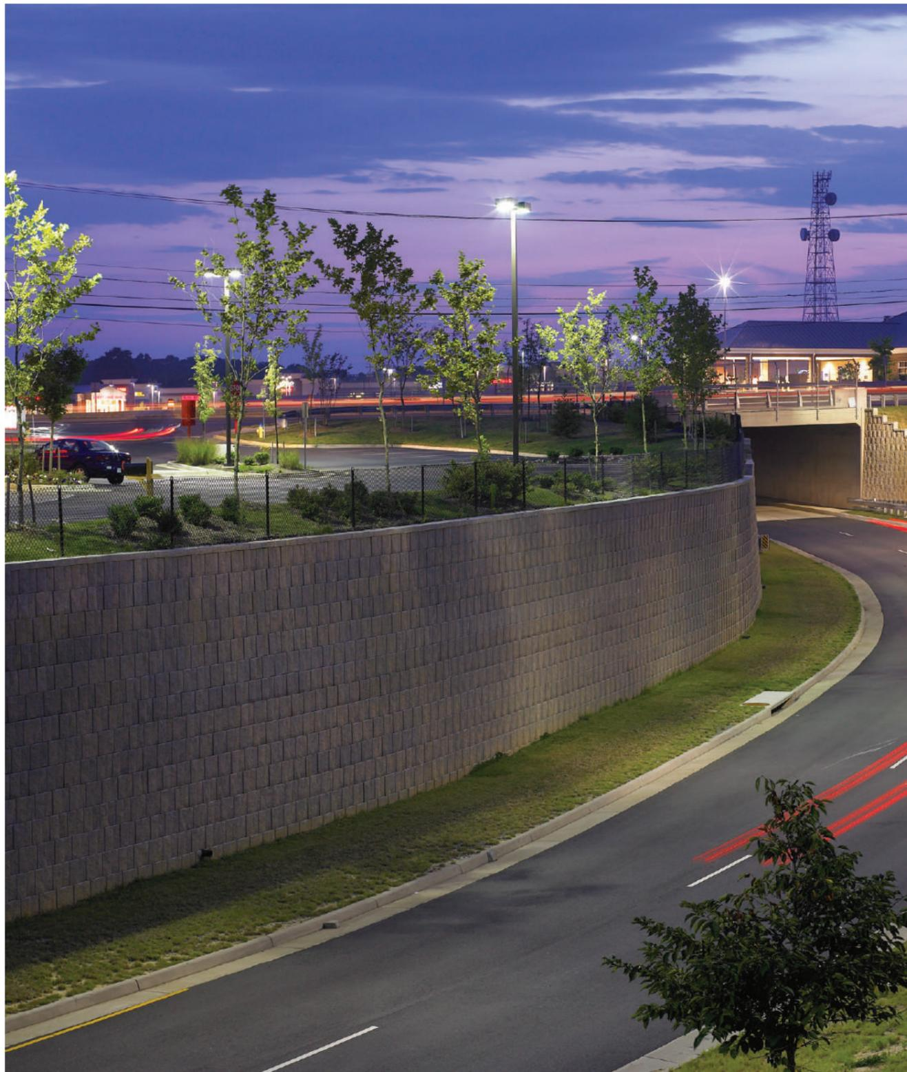
LANDMARK® è la nuova generazione di murature di contenimento in terra rinforzata e rappresenta un deciso passo avanti nell'ambito dell'ingegneria geotecnica.
