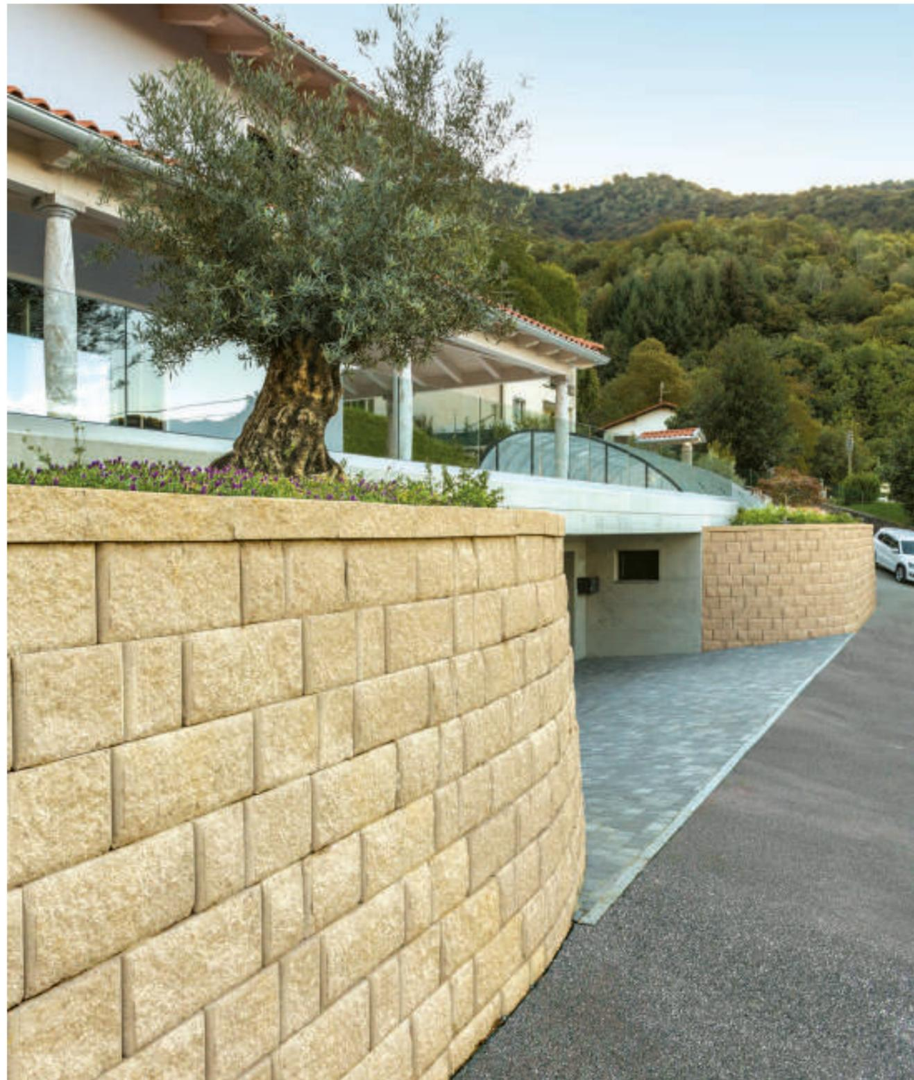
VERTICA® VJ è un sistema estremamente duttile, che permette di realizzare murature molto performanti: curve, angoli, diramazioni e terrazzamenti.
