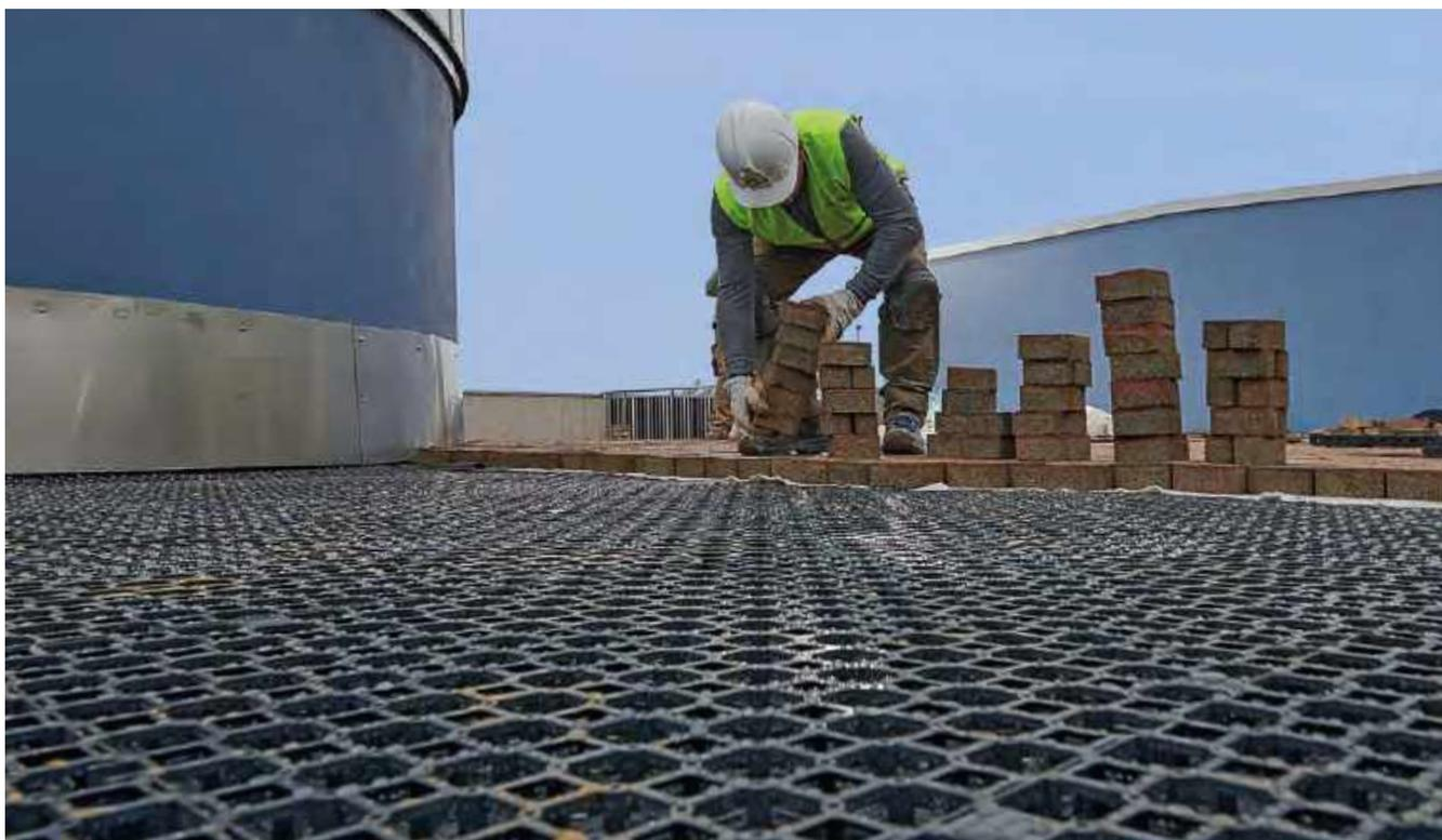
Geocell è una griglia ad alta resistenza realizzata in Graplene rigenerato per il drenaggio diffuso dell'acqua sotto le aree pavimentate.
