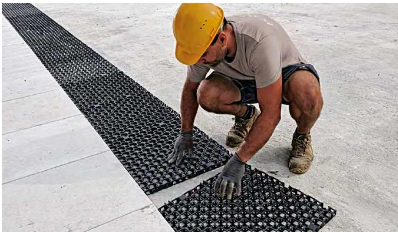
Geocell è idoneo per qualunque fondo di posa se regolarmente compattato. Grazie all'aggancio innovativo, la griglia risulta semplice da posare. La modularità e la notevole velocità di posa permettono un processo di lavorazione agile e flessibile.
